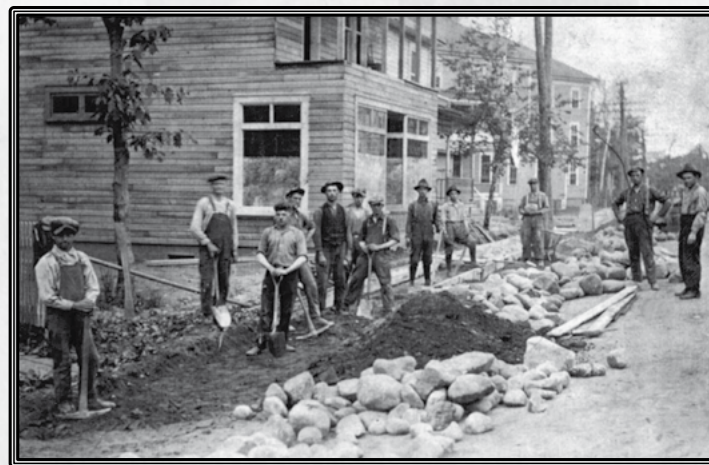
Construction de trottoirs, fin des années 1920. (Collection Claude Frenette & Patrimoine et musique)
