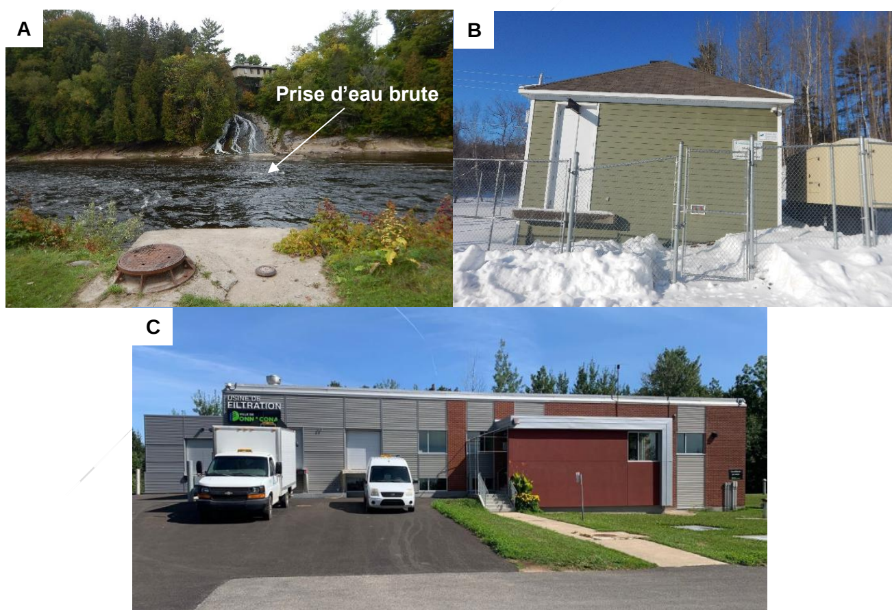
Figure 4 : Photographies de A) la prise d'eau brute en septembre 2019 (CBJC, 2020), B) l'installation de prélèvement en février 2020 (CBJC, 2020), et C) l'installation de production (Tetra Tech, 2022) X0008121-1 de la Ville de Donnacona
