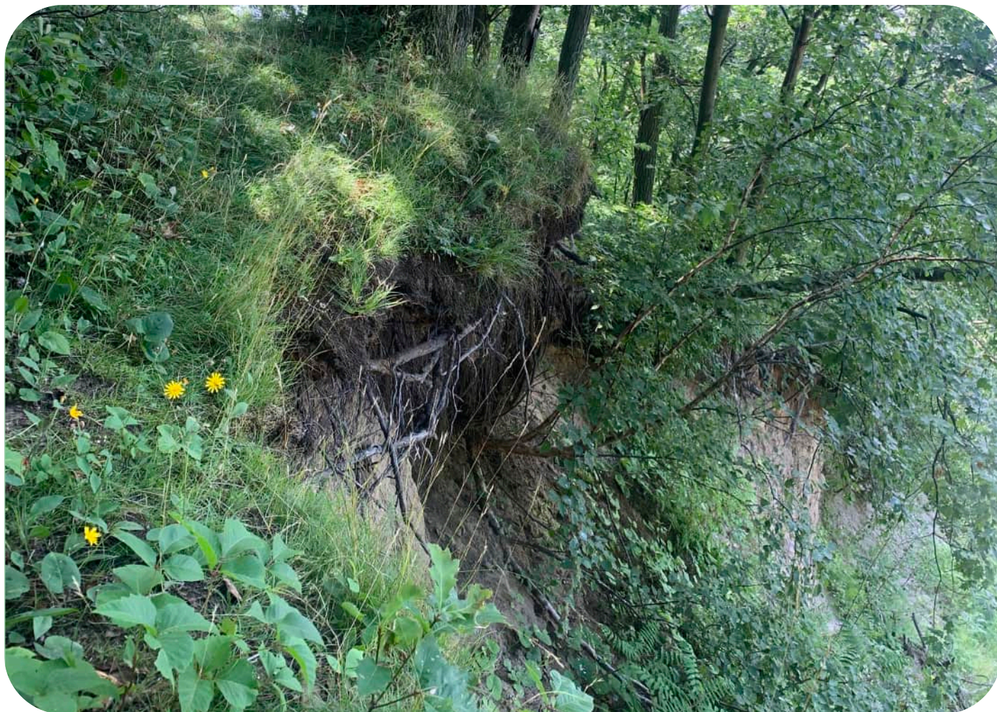
PHOTO 4 • TRACES D'ÉROSION D'UN TALUS SUR LES BERGES DE CAP-SANTÉ
